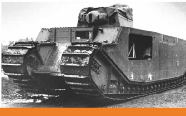
◀ De complete romp van TOG 2, met de dummy toren en in de zijwanden de openingen waar de sponsons moesten worden geplaatst.
